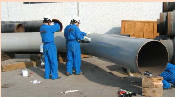
Application of FibaGel primer
